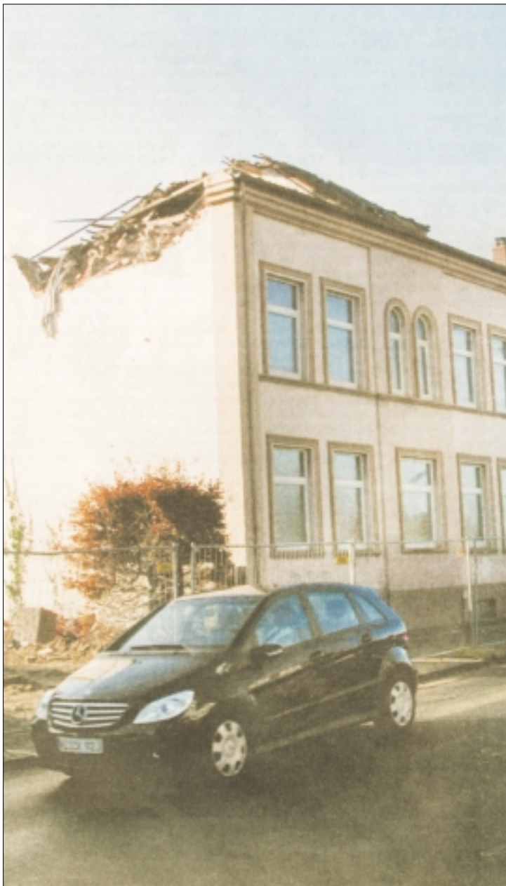
Das Haus in der Hildesheimer Straße 28 hat schon kein Dach mehr. Im September 2007 sollte in dem Neubau ältere Menschen einziehen können.
