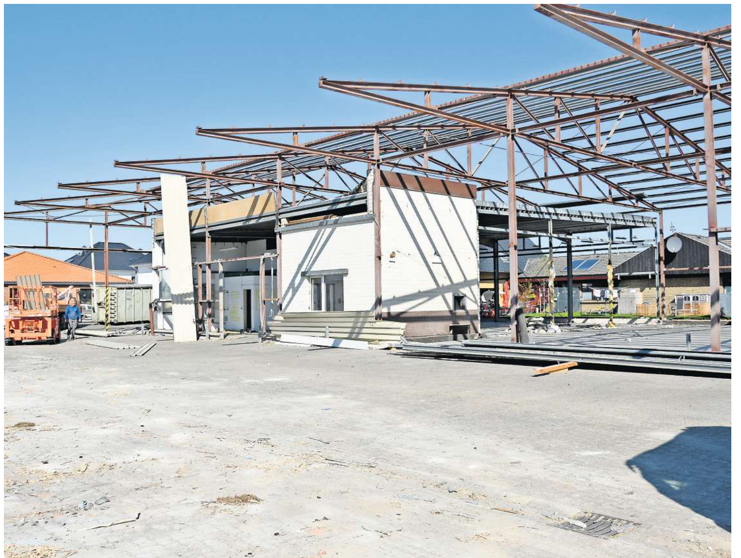
Was derzeit noch eine Abriss-Baustelle ist, soll schon bald zu einer einladenden Wohnanlage für Senioren werden.
