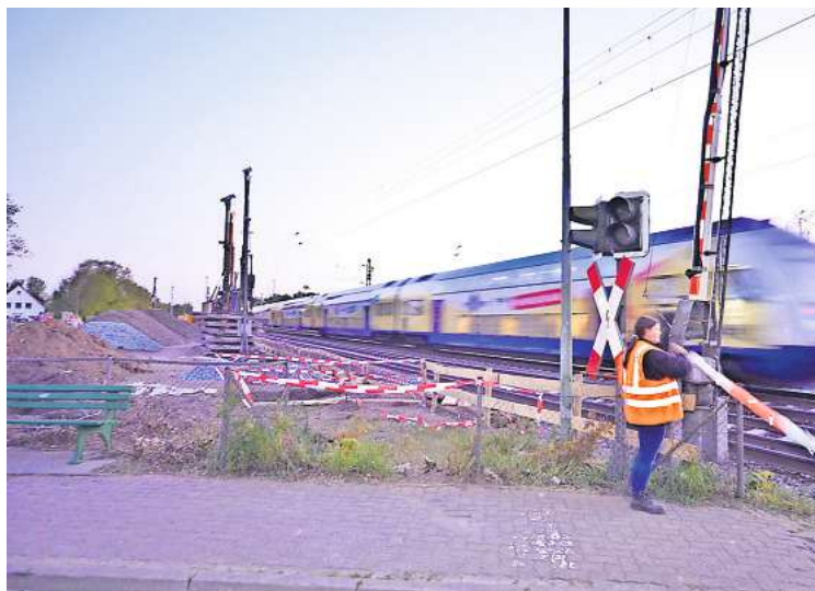
Gegen Abend, wenn der Bahnverkehr anders getaktet ist als tagsüber, erwacht die Baustelle erst so richtig zum Leben.
